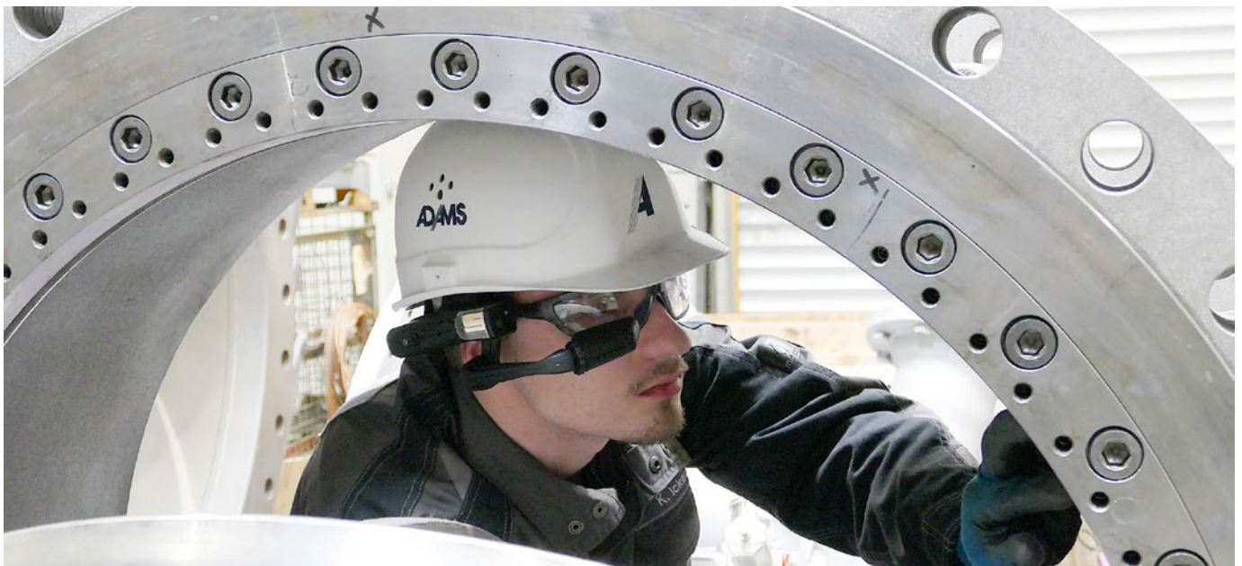
AR-Technologie unterstützt Service-Einsätze
